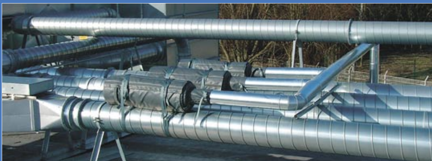
Защита от мороза с помощью изолирующих кожухов
